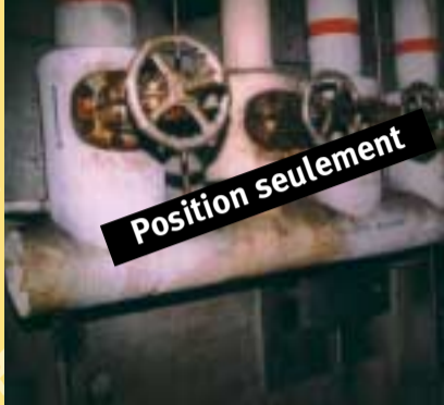
Calorifugeage (isolation) d'amiante sur des tuyaux
